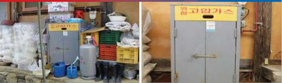
개선전 | 가스용기보관소 주변에 가연성 물질이 산재해 화재 위험이 높음 개선후 | 가스용기보관소 주변 정리 및 청결 유지
