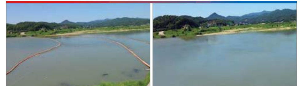
개선전 | 공사장 주변의 하천오염을 방지하기 위해 설치된 오탐방지막은 우기 시에는 유수의 흐름 방해 및 범람을 유발할 수 있음
