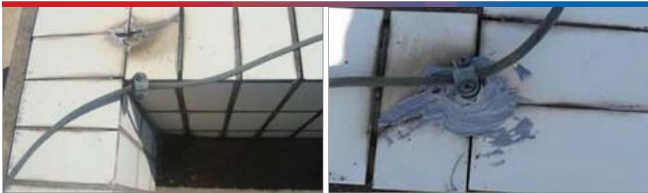
개선전 | 피뢰침 접지도선 고정볼트가 느슨하여 탈착되어 있는 상태 개선후 | 피뢰침 접지도선 볼트 고정
