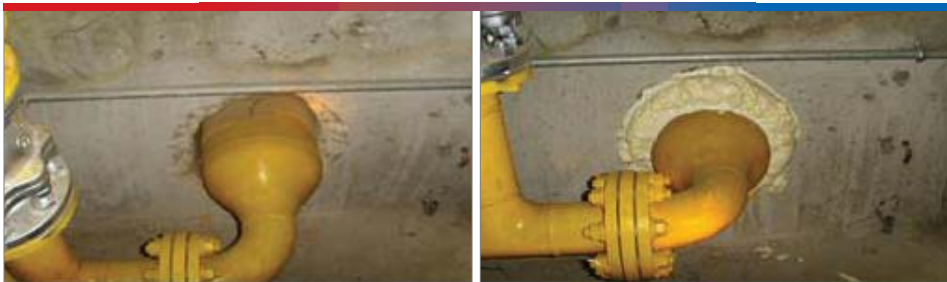
개선전 | 벽관통 배관에 마감이 이루어지지 않아 누수 및 배관파손 우려가 있음 개선후 | 벽관통 부위에 마감재 시공
