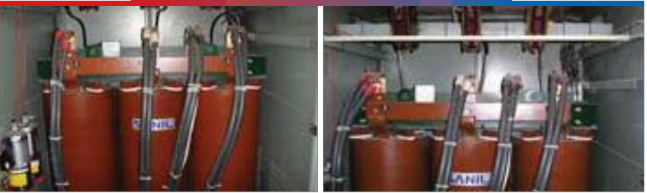
개선전 | 변압기 보호지지대 미설치 개선후 | 보호지지대 설치
