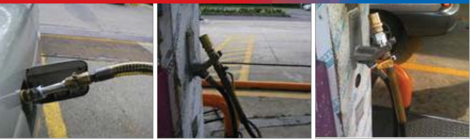
개선전 | 충전기 밸브핸들 제거, 충전 후 밸브잠금을 하지 않아 개방된 상태
