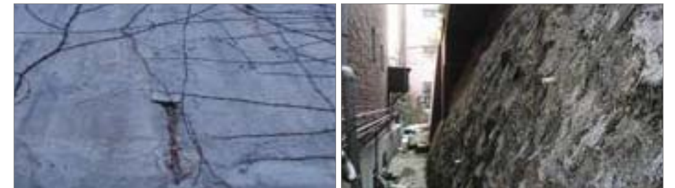
균열이 발생한 아파트 웅벽 주기적인 안전점검 및 정밀 안전진단이 필요하다
