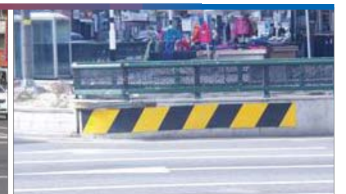
개선후 | 지하철 출입구 외벽에 안전시설을 설치하여 충돌사고를 예방함
