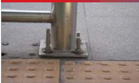
개선전 | 승강장의 안전난간 고정용 볼트가 튀어나와 발에 걸릴 위험이 있음
