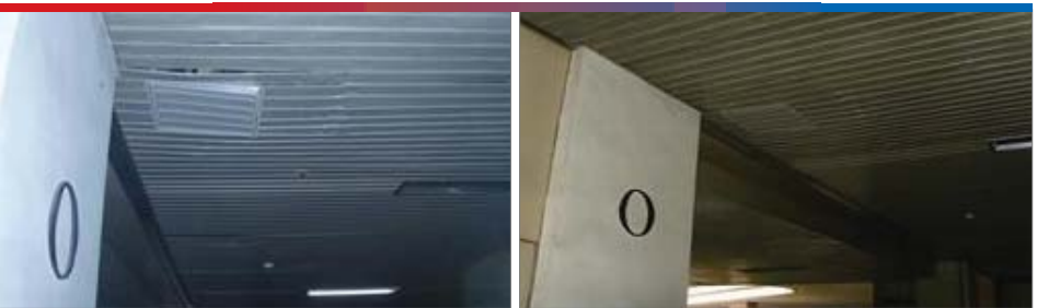
개선전 | 천장 점검구에 처짐 발생으로 안전사고 발생 위험이 있음 개선후 | 천장 점검구의 처짐을 개선함
