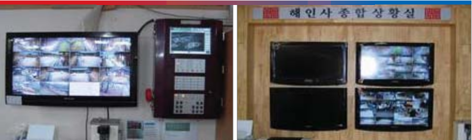
개선전 | 단순히 감시카메라와 연동된 모니터 설치로 효과적인 대응 곤란 개선후 | 근무자의 시야와 효율적인 산불감시를 고려한 종합상황판 설치
